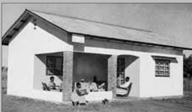
Maison construite avec l'aide du F.B.I. et du Fonds d'avance dans un paysanat indigène à Gandajika. Photo C. Lamotte, Congopresse
