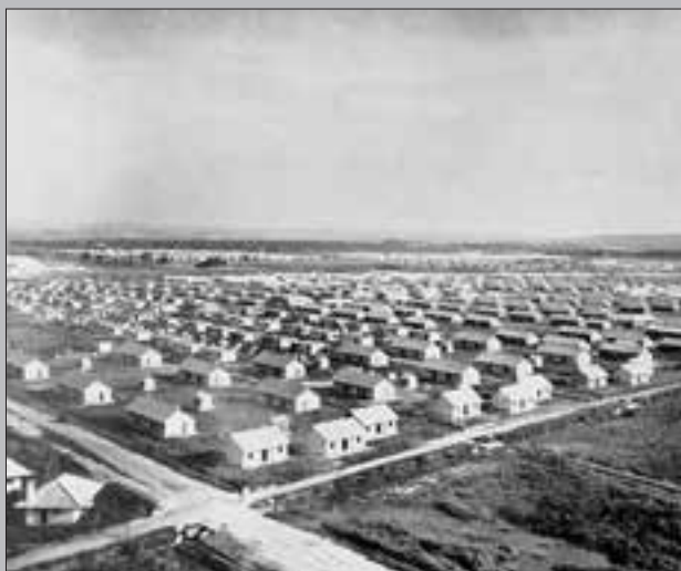
L'O.C.A. avait reçu mission de construire des logements dans les cités des grands centres. Au 31 décembre 1959, il avait réalisé un peu plus de 20.000 maisons dans les quartiers indigènes de Léopoldville. Ici, une vue du quartier Renkin à Léopoldville. F. Pierot, « Lumière sur l'Afrique belge », 1958
